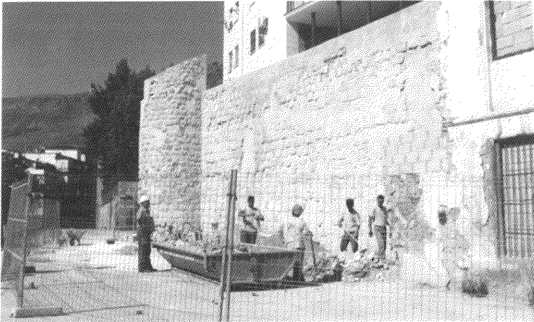
Restauración preventiva Muralla Sur
