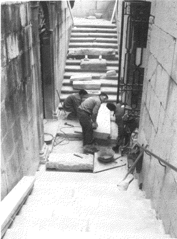
Restauración escalera de acceso norte. Catedral de Jaén.
