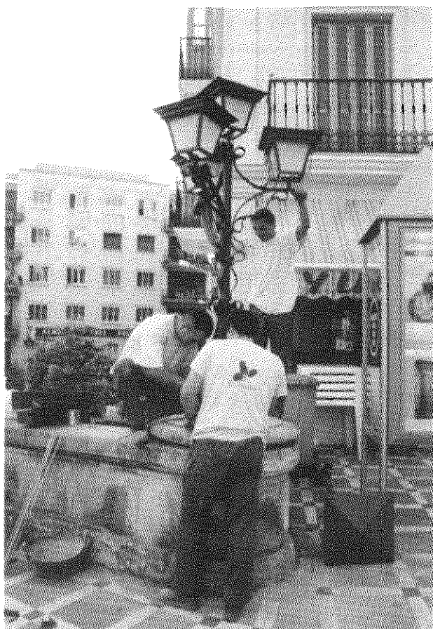
Instalación de farolas en el Pósito.
