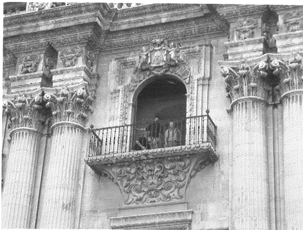
Reparación puertas de balcones de la Catedral de Jaén
