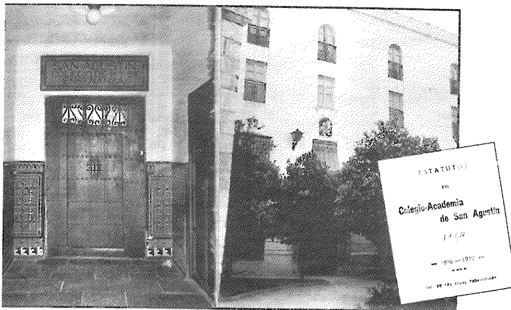
Zaguán del Colegio de San Agustín y fachada del mismo Colegio remodelada hacia mediados de los años 50
