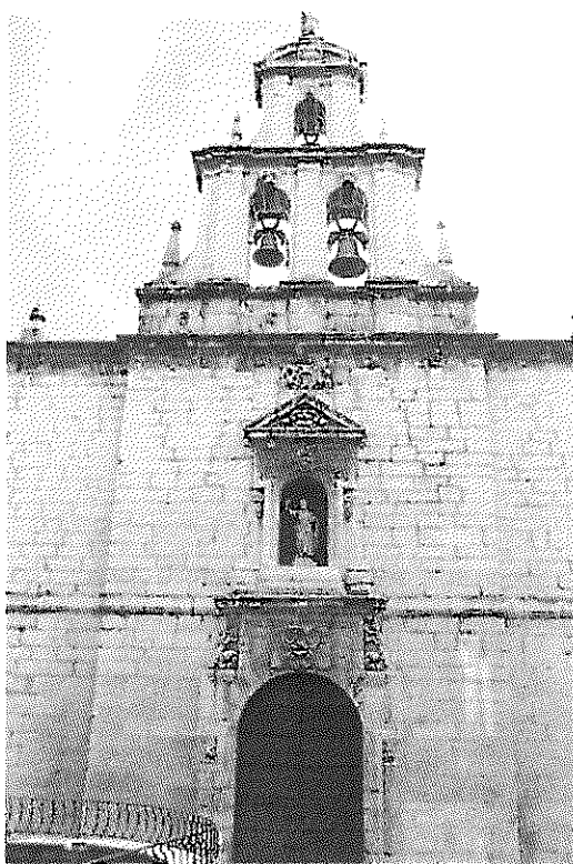
Iglesia de San Bartolomé de Jaén. Fachada principal
