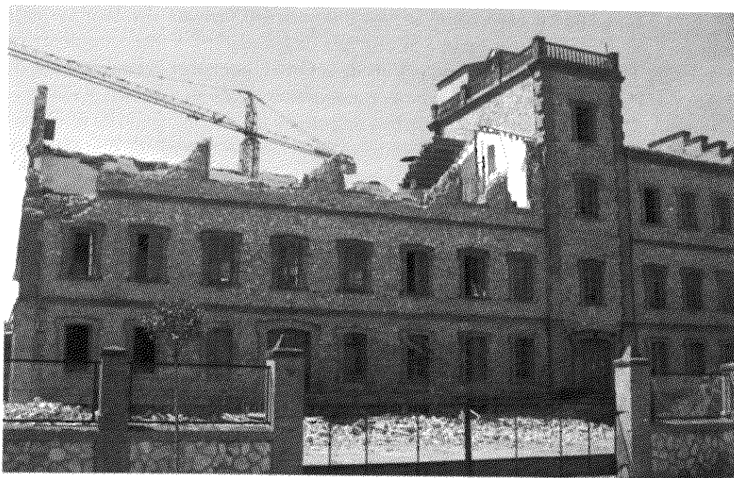
Una fábrica harinera prototipo... Fotografía tomada al inicio de su demolición
