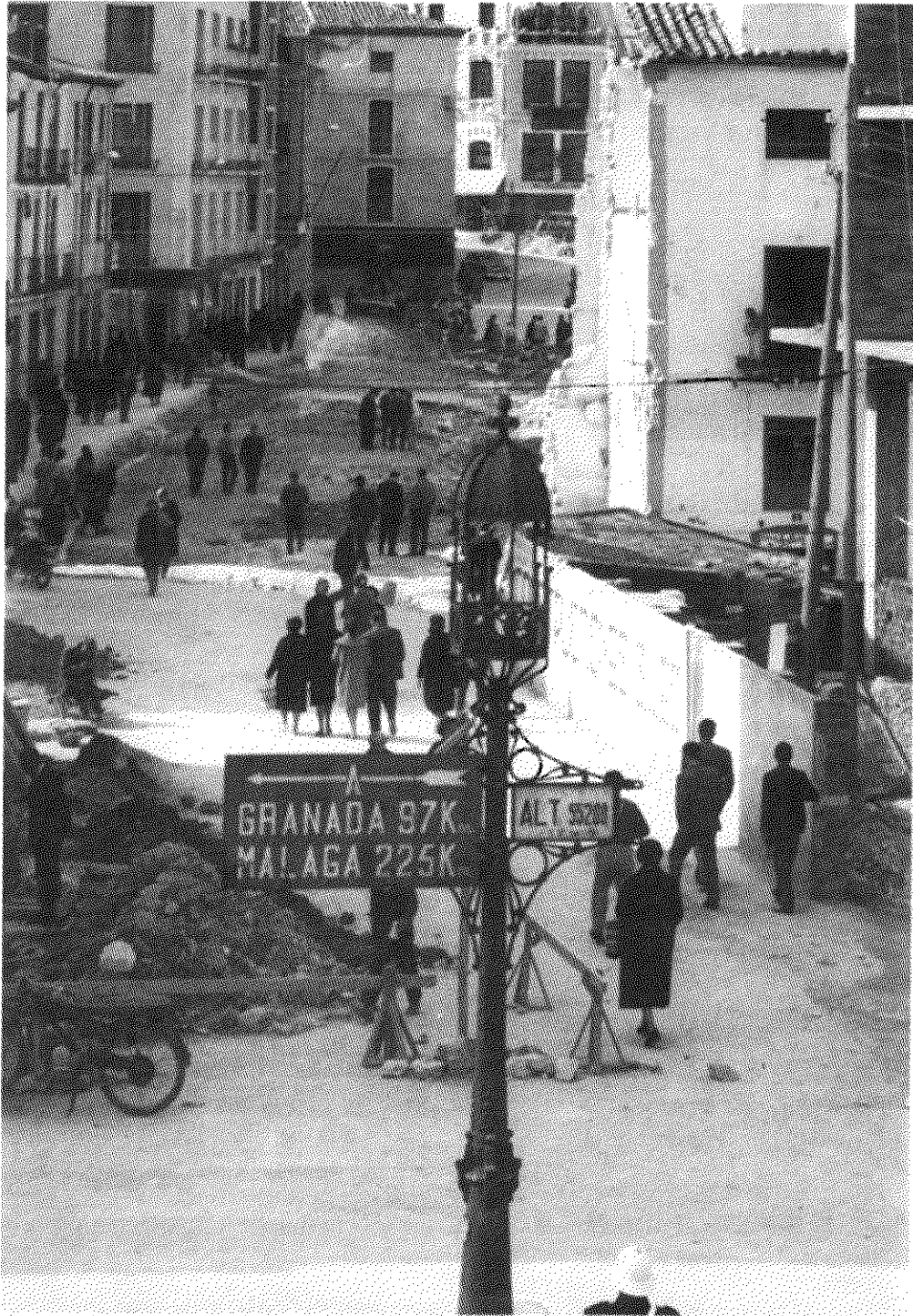
Desaparecida farola que tantos años estuvo en la Puerta Barrera, indicando a los viajeros la dirección hacia Granada y Málaga y marcando la altura de Jaén –552 metros– sobre el nivel del mar.- (Corresponde la fotografía a las obras de ensanche de la calle Julio Burell, para convertirse en la actual Virgen de la Capilla).
