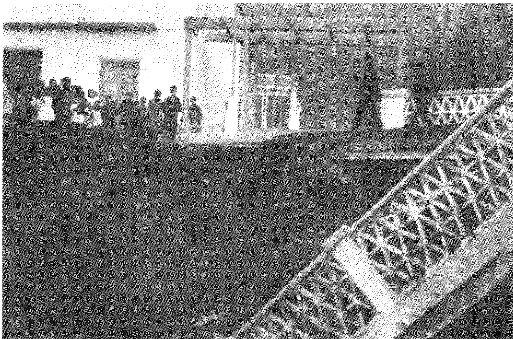
Hundimiento del Puente del Arroyo, año 1966. (Foto: P. de la Torre)
