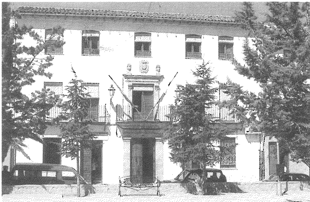
Fachada principal del Ayuntamiento
