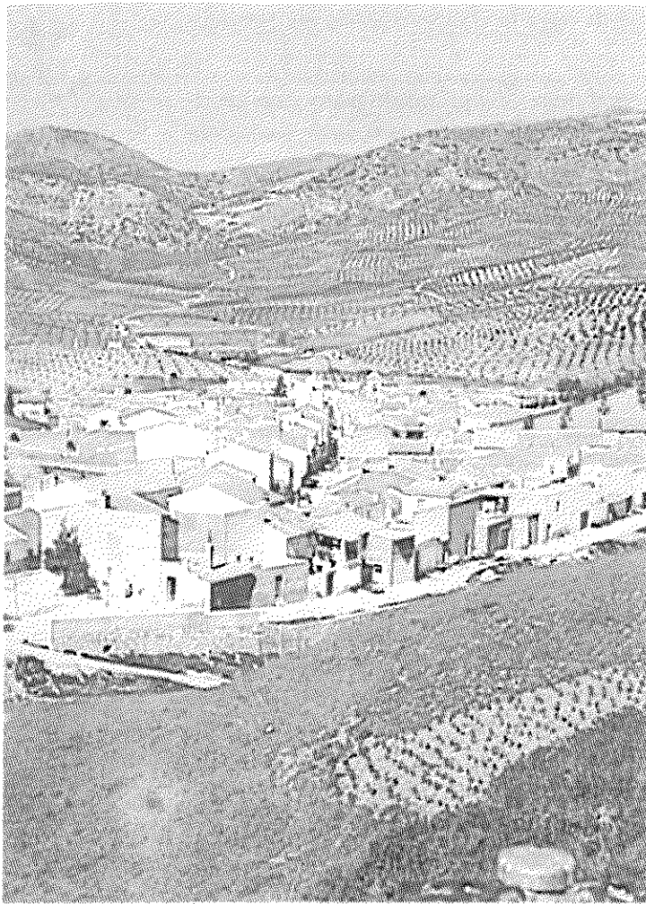
Vista parcial de Campillo desde la autovía
