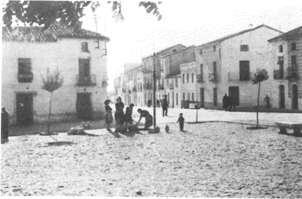
Plazoleta de la Plancha, h. 1950
