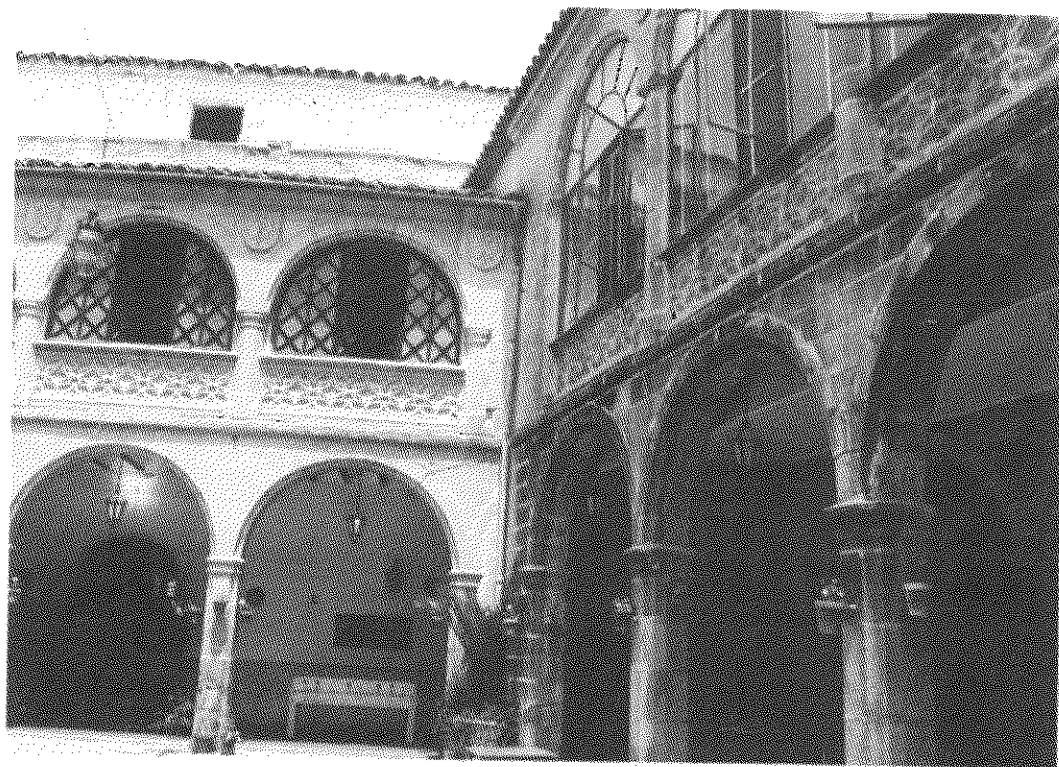
Patio porticado del Casino
