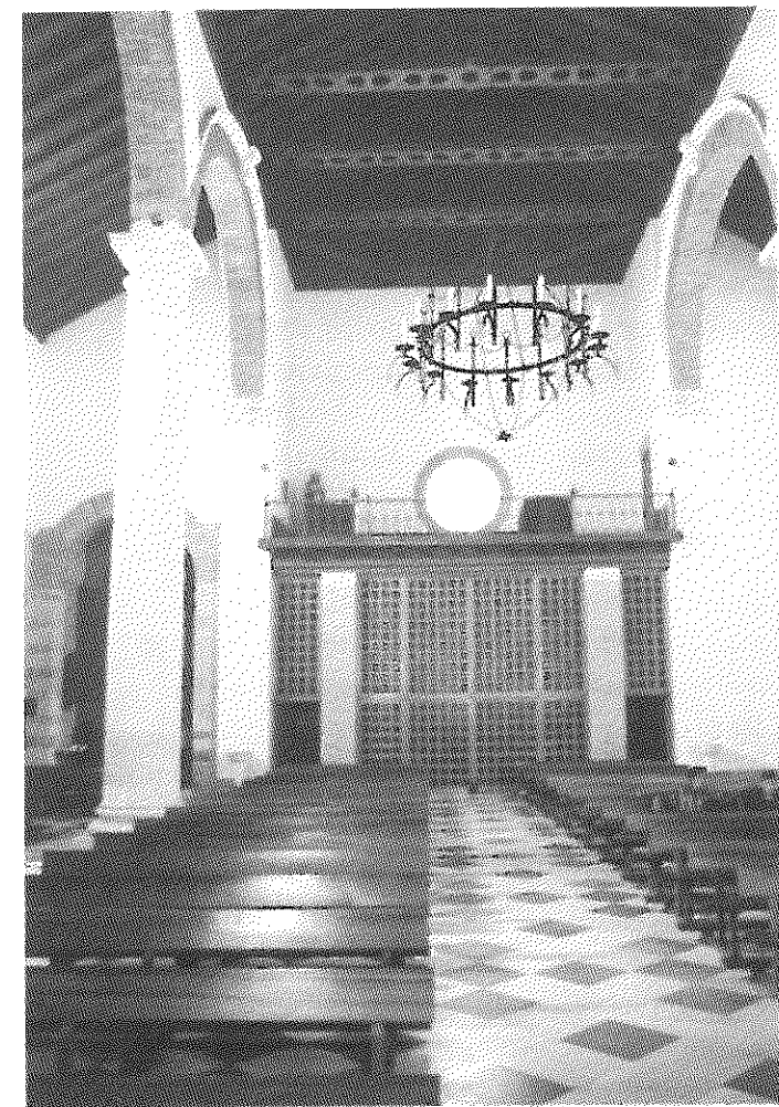
Fig. 8.— Iglesia de San Pedro. Interior, nave central y coro
