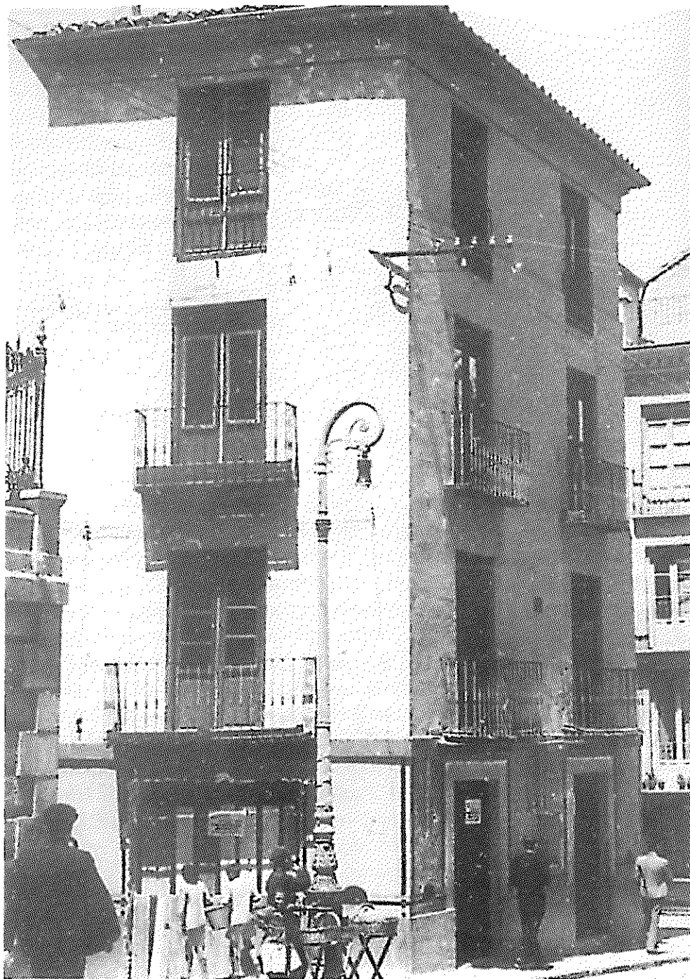
Esta era la casa n.º 1 de la calle Bernabé Soriano, justo a la entrada a la calle Joaquín Tenorio, demolida en el año 1948, para un mejor acceso al Mercado de San Francisco.- Fue propiedad de D. Rafael Jaén Jaén y allí estuvo su famosa sombrerería. (Foto de Archivo).
