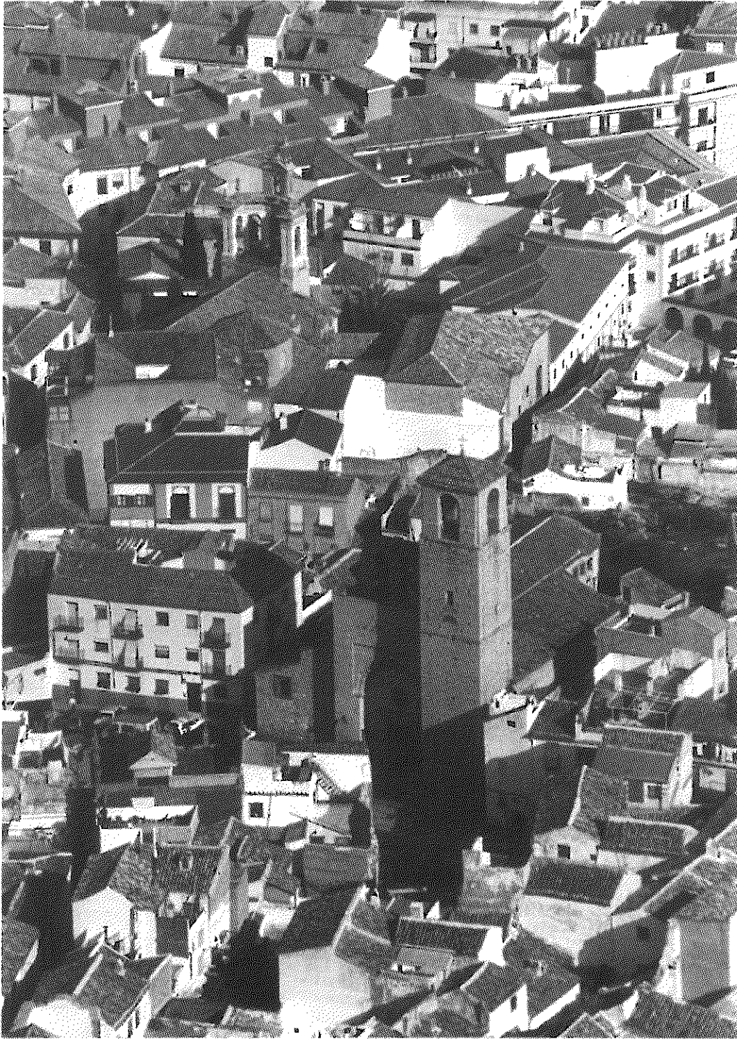
Vista aérea de los barrios de San Juan y San Andrés, en Jaén, con la Torre del Concejo en primer término.
