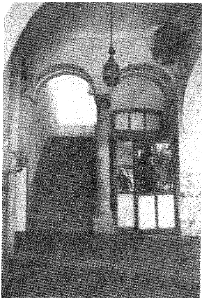
Hospital de San Juan de Dios. Escalera de subida a las plantas donde estaban ubicadas las salas de enfermos
