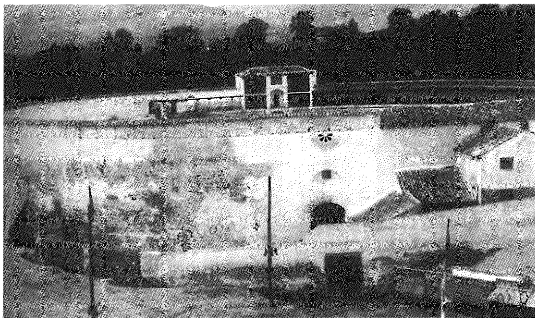
Antigua Plaza de Toros de Jaén
