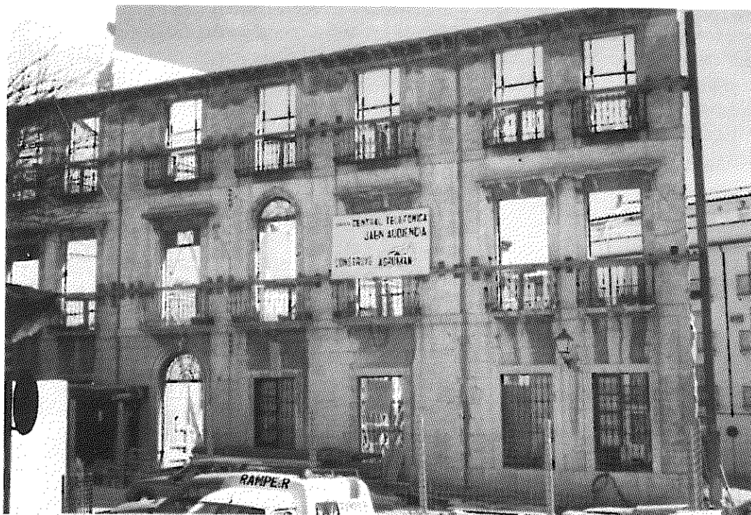
Obras de Conservación de la fachada de la Casa de los Coello. Año 1990.- (Foto de D. Fernando Cabezado Sánchez)
