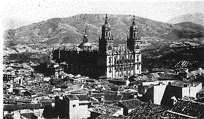
Vista parcial y Catedral de Jaén.
