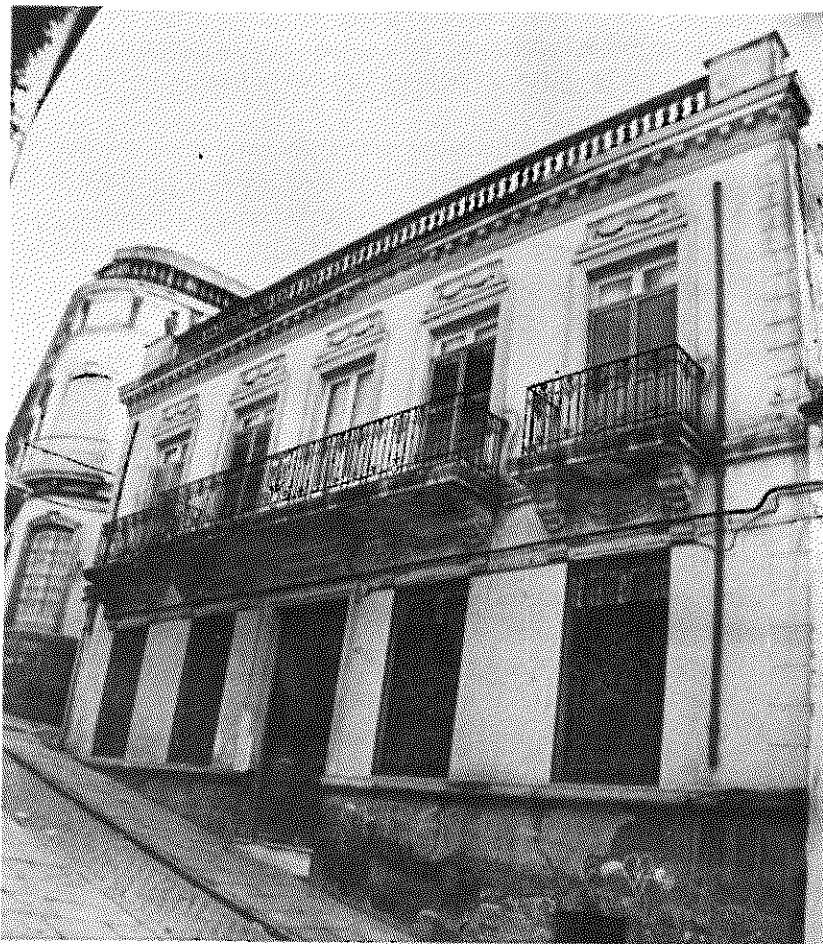
Última residencia de las clarisas de Martos. Edificio de principios del siglo XX, en la calle del Arbollón .
