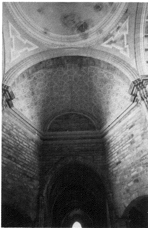
Interior de la Iglesia.
