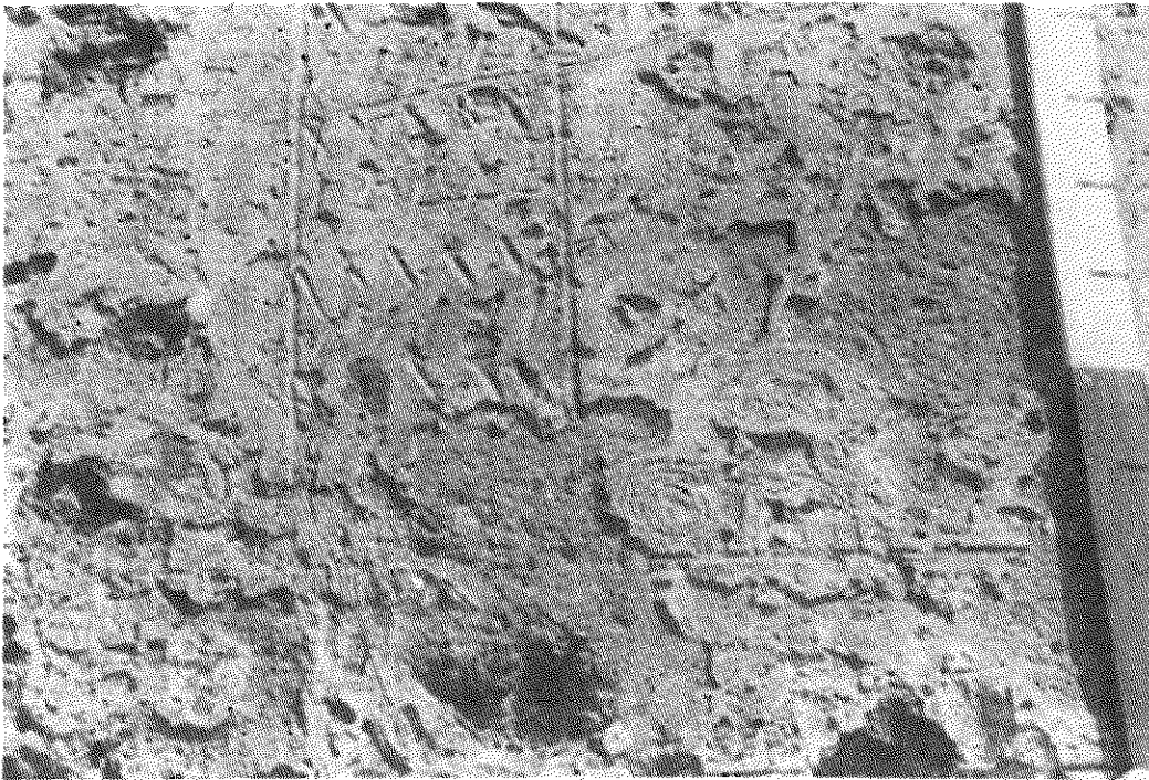
Fotografía n.º 1. Franja decorativa impresa en los muros del castillo de Baños de la Encina. Las marcas pequeñas de la escala miden 5 ctns. (Ferrer Morales, 1992).
