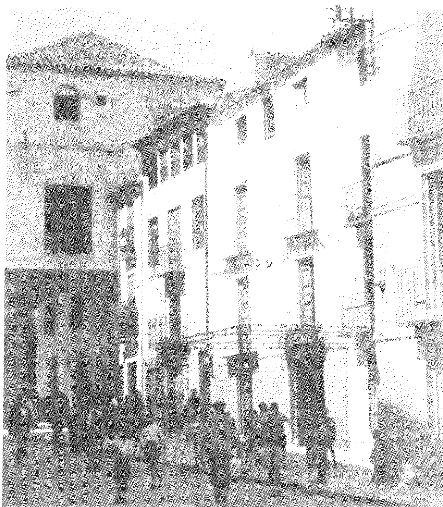
Fachada de la Posada del León .
