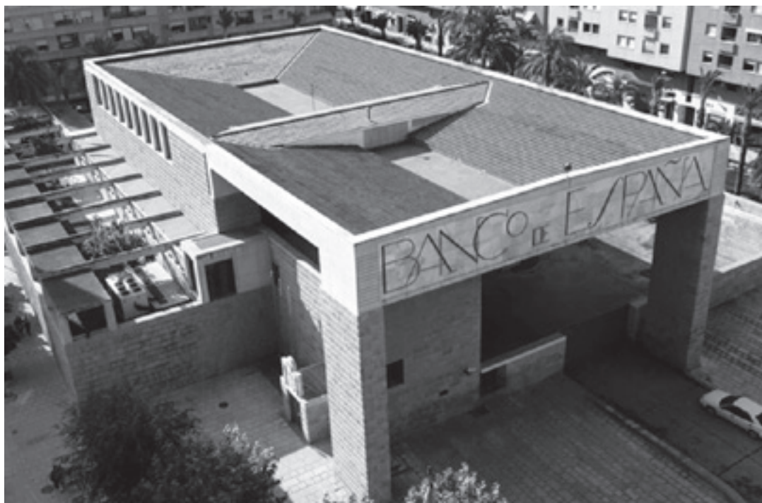
Vista general del Banco de España
