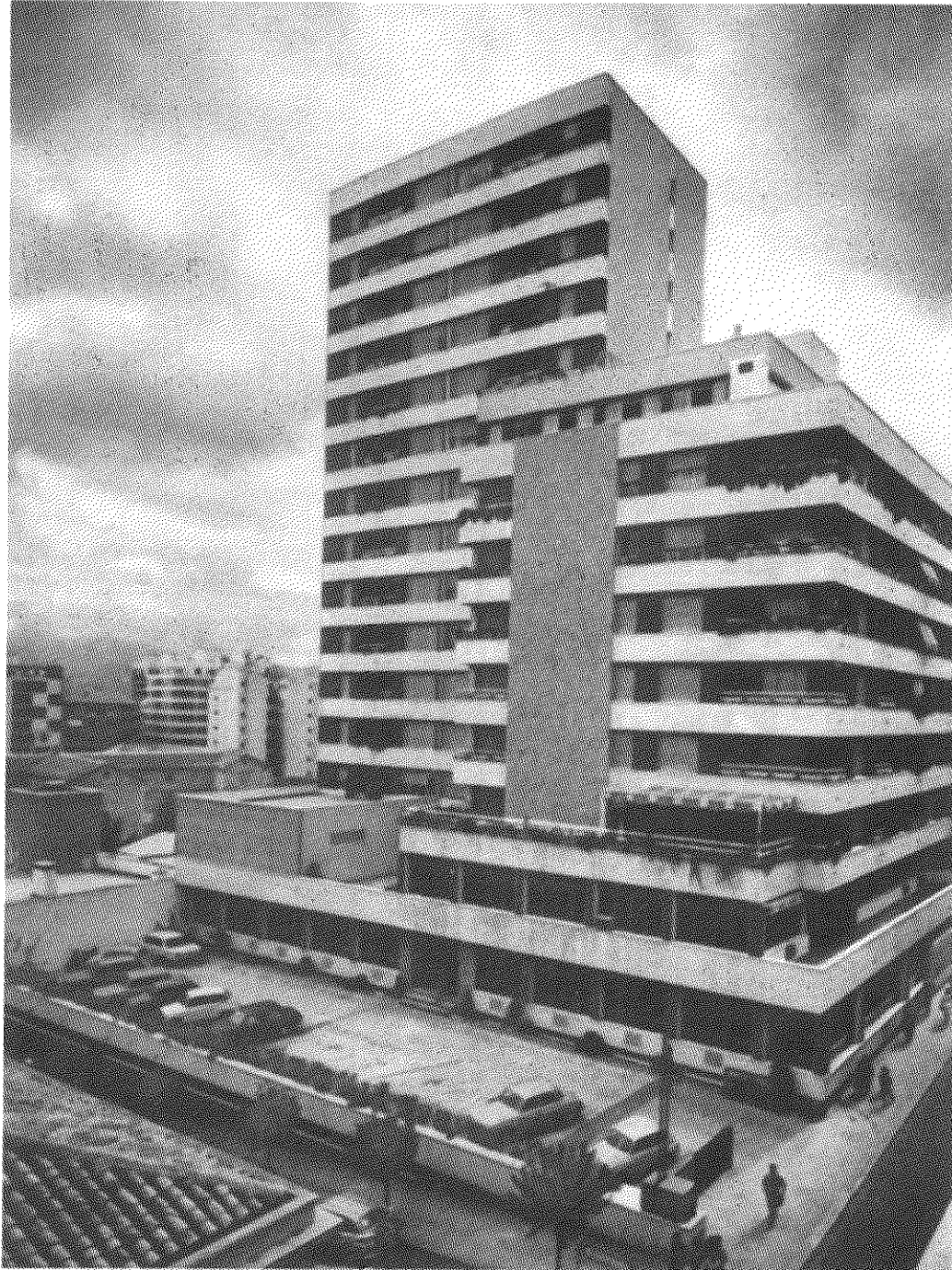
Edificio del Colegio Oficial de Farmacéuticos, en cuya sede se celebró la Cena Jocosa del año 2007
