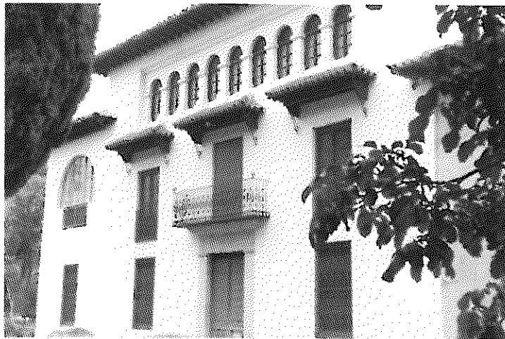
Fachada de la Casería de La Vereda
