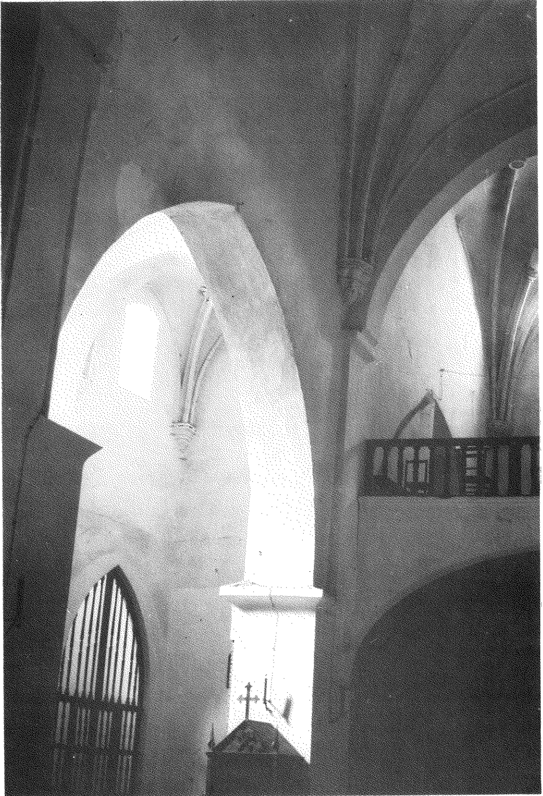
Interior de la Iglesia de La Magdalena antes de su restauración.
